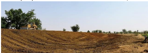
(aanleg van een van de zes dammen)
